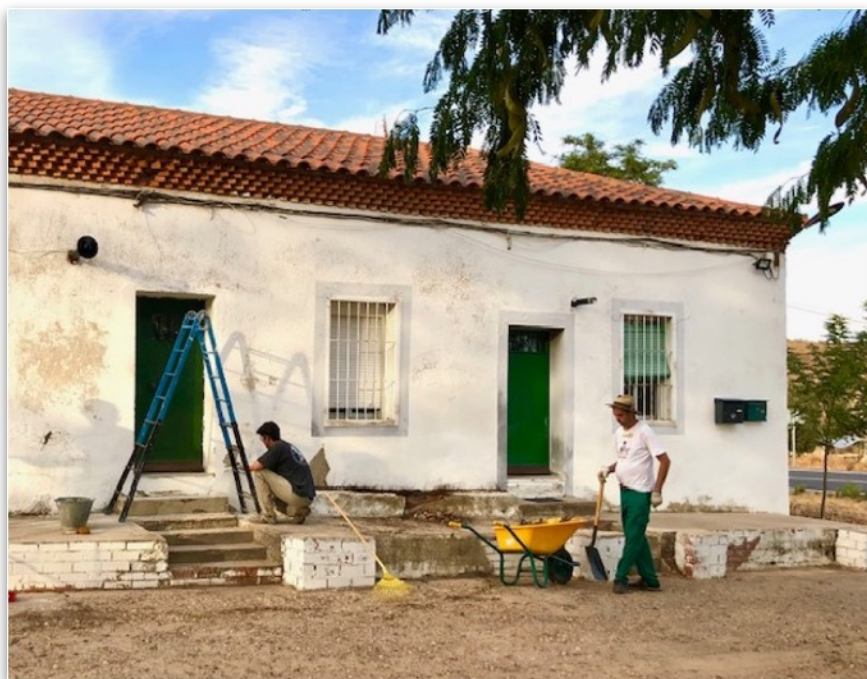
Raúl, durante las tareas de adecuación de su nueva casa
